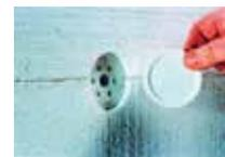
4. mise en place de la rondelle isolante STR
