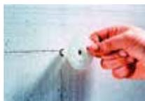
2. insérer la cheville avec vis prémontée jusqu'à ce que la rosace soit en contact avec l'isolant
