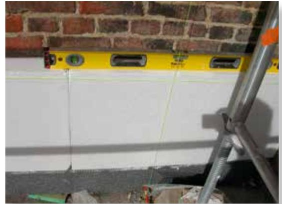
Pour coller les panneaux d'isolation, utiliser le Mortier de Collage et d'Égalisation WILLCO ou le Mortier de Collage et d'Égalisation Multilight Plus. Si le support est constitué de bois, employer le Mortier de Collage Dispersion Gros WILLCO. Pour appliquer ce mortier de collage sur les panneaux d'isolation, on peut pratiquer de deux façons :
