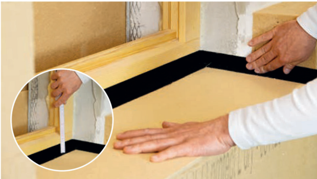
6 Hoogte-afstelling, het resterende scheidingspapier (wit) verwijderen en de STEICOMulti tape black rondom aandrukken.
