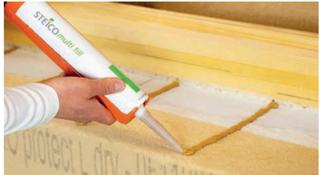
4 Bevestig de isolatie, afhankelijk van de inbouwhoogte, met STEICOMulti fill in lijmbanen.
