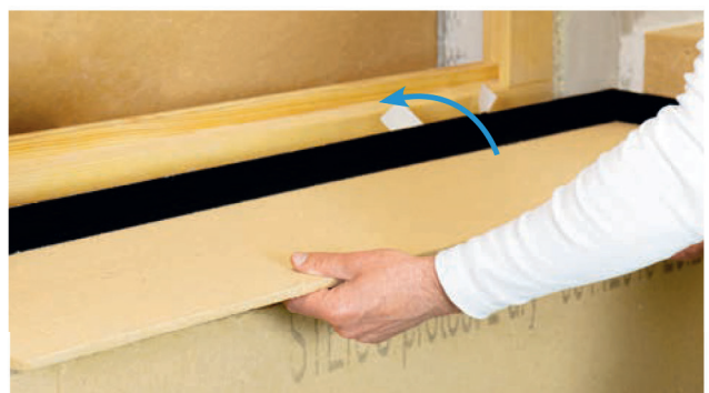
5 Plaatsing van de STEICOTri vensterbankisolatie: onder druk volledig in de lijm laten zakken. Tip: Vouw het scheidingspapier (wit) terug om het gemakkelijk te kunnen verwijderen.
