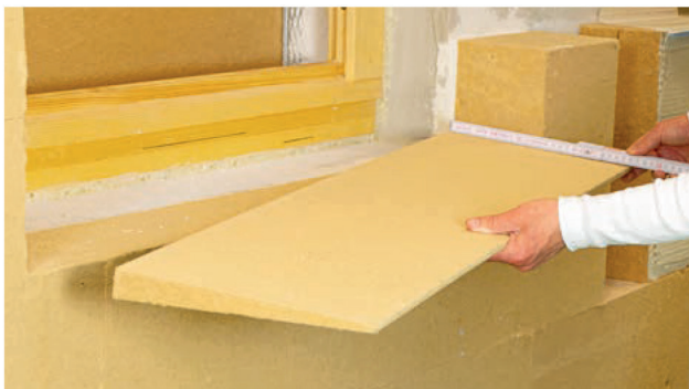
1 De STEICOTri vensterbankisolatie op de juiste lengte en diepte van de raamopening zagen.
