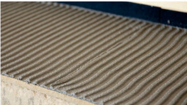
8 Het uitvlakken in de richting van de helling gebeurt met een tandtruwiel van 6 mm om een droge laagdikte van min. 4 tot max. 10 mm te verkrijgen.
