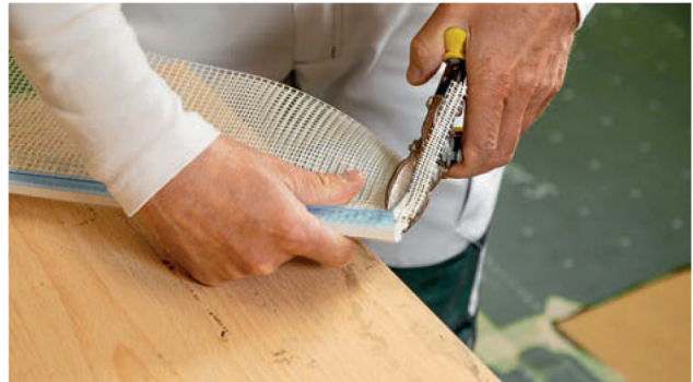
9 Snijden van WILLCO Glasvezel Wit Fijn, hoek- en aansluitprofiel WILLCO 5400.
