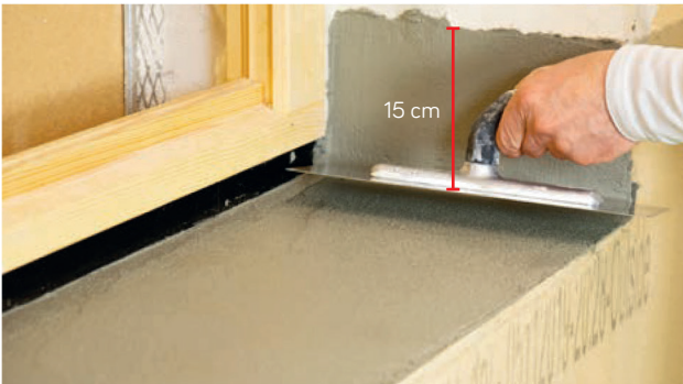
7 Egaliseren van vensterbankisolatie met WILLCO Flexfix S. Hoogte mortel aan dagkant = 15 cm.
