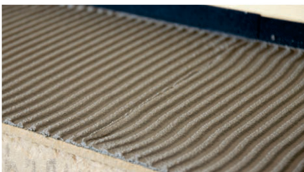
8 L'égalisation dans le sens de la pente s'effectue à l'aide d'une taloche dentée de 6 mm afin d'obtenir une épaisseur de couche sèche comprise entre 4 mm minimum et 10 mm maximum.
