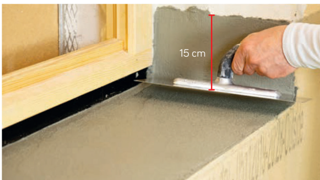
7 Égalisation de l'isolation d'appui de fenêtre avec Flexfix S WILLCO. Hauteur du mortier au niveau des baies = 15 cm.
