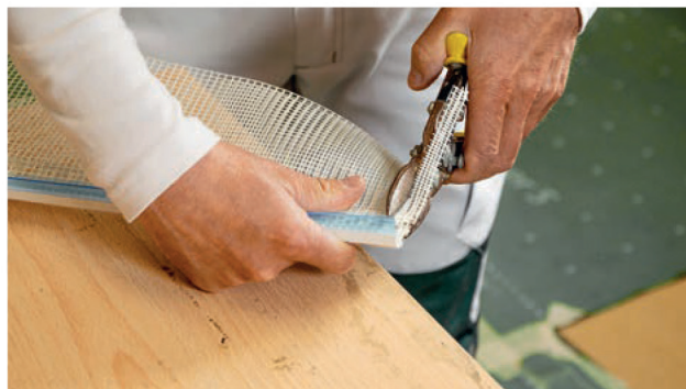
9 Découpe le profil d'angle, le profil de raccordement 5400 WILLCO et le Fibre de Verre Blanche Fine WILLCO.
