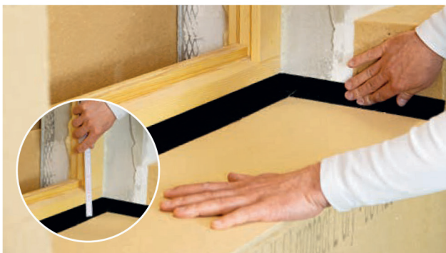
6 Ajuster la hauteur, retirer le papier de séparation (blanc) restant et appuyer sur le STEICOMulti tape black tout autour.
