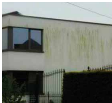
Fig. 33 & 34: algues et moisissures avant et après traitement (produit désinfectant)
