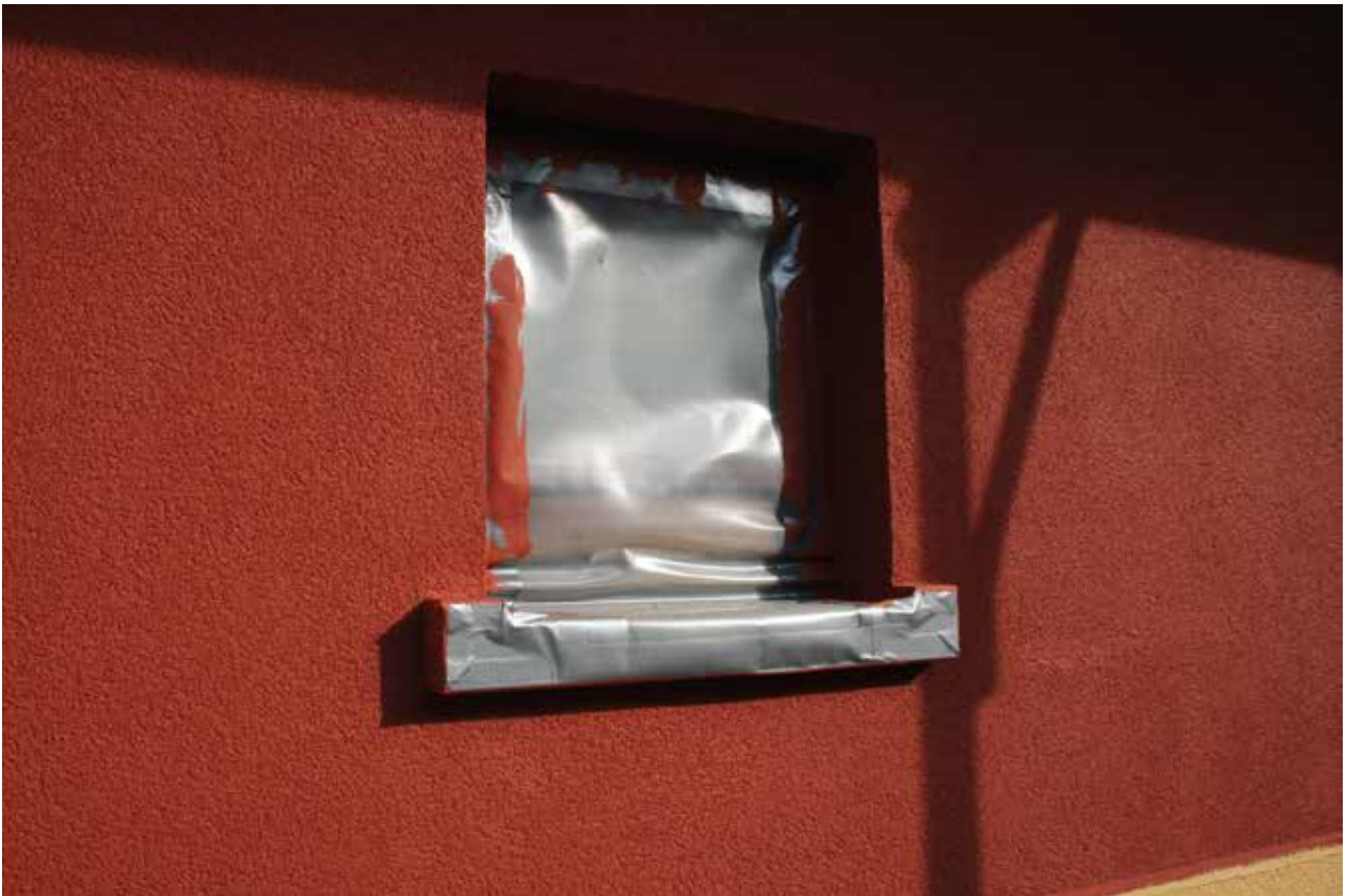
Fig. 42: détails application peinture
