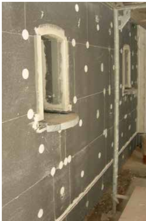
Fig. 15: Ancrage supplémentaire de l'isolant
