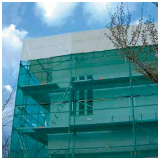
Fig. 8: Echafaudage pouvu d'un voile
