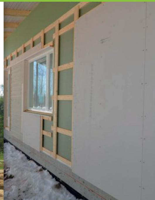
Le système WILLCO Aventi est un système de façade ventilé qui se compose notamment d'un panneau en fibres-ciment enduit de plâtre. Le panneau est recouvert des deux côtés de fibre de verre et est appliqué sur une structure portante en bois.
