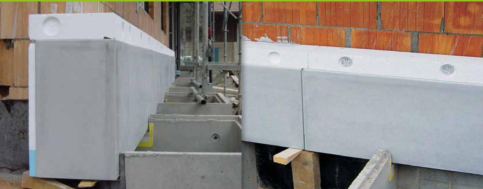
La Plinthe WILLCO est une plinthe de finition intégrant une isolation dans un même élément. Elle est utilisée dans la gamme de plinthes d'un Système d'Isolation de façade extérieure WILLCO, et protège le pied de mur de la façade contre les dommages et les projections d'eau.
