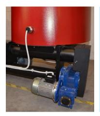
Le réservoir a une capacité de 370 kg de biomasse. En option, un réservoir plus grand est disponible. Un motoréducteur entraîne les 2 vis d'alimentation. La vis d'alimentation double évite le risque d'incendie dans le réservoir. Les vis sont prévues d'un raccordement à un extincteur automatique.
