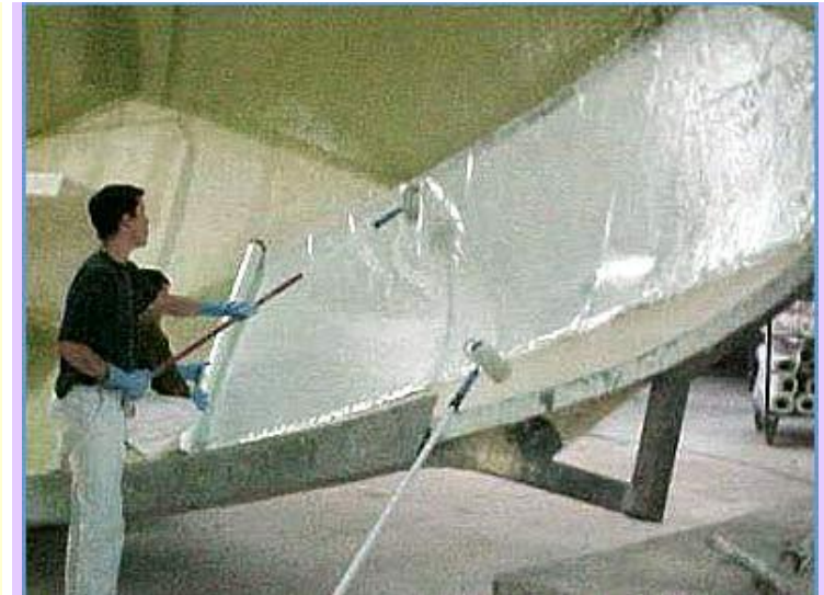
Foto: voorbeeld van het handlamineren
