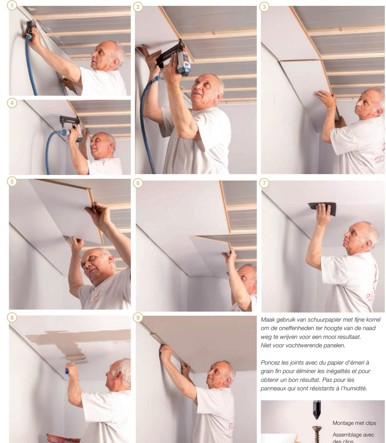
Het gebruik van clips referentie 1513 wordt sterk aangeraden bij oppervlakken groter dan 20 m<sup>2</sup>. Voor de montage van de plafondpannen raden we aan gebruik te maken van de montagekit. Deze bestaat uit een aanslagblok en een geleidingsstuk.
