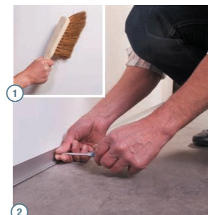
1. Laat de panelen acclimateren en zorg dat de ondergrond voldoende vlak, droog, vast, zuiver, stof- en vetvrij is\*. De ondergrond lichtjes opschuren geeft een beter resultaat. Laissez acclimater les panneaux et veillez à ce que la surface de la paroi soit suffisamment plane, sèche, solide, dépoussiérée et dégraissée\*. Un léger ponçage de cette surface fait obtenir un meilleur résultat.
