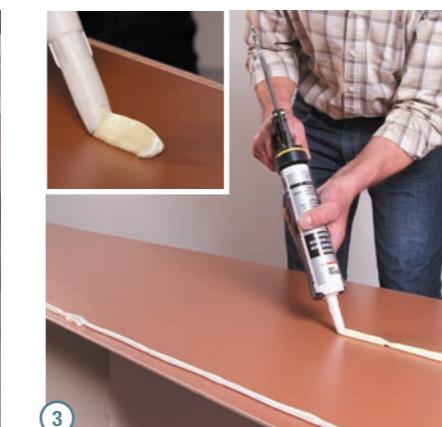
Werk met de klok mee. Breng een elastische, sterke montagelijm\*\* aan op de achterzijde van het paneel: 3 lijnstrengen in de lengte richting van de plaat. Plaats het paneel tegen de wand en druk goed aan.
