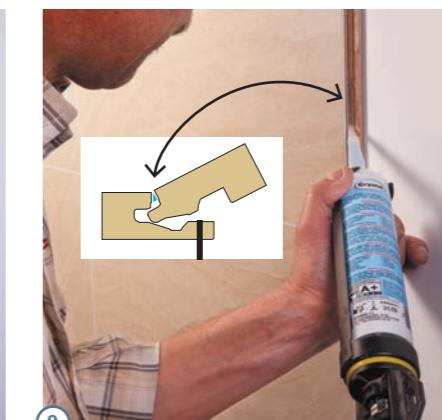
In de nog vrije hoek wordt het profiel bevestigd tegen de muur. Breng opnieuw silicone in het profiel, zaag de groef van het eerste paneel dat in het profiel moet en werk verder.
