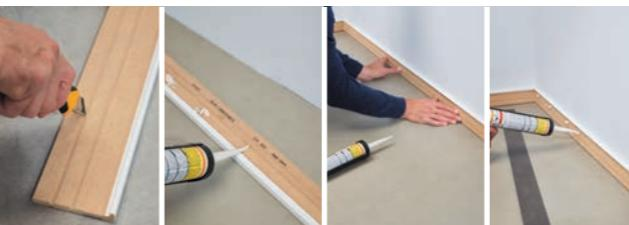
NL Pas de hauteur aan met een breekmes. Plaats de plinten en verzaag de vloerpanelen in stroken. Deze stroken klik je in elkaar aan de korte zijden en lijm je vast in de plint.
