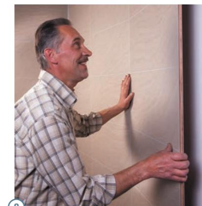
Voorzie in elke verticale voeg (in de profilvering) sanitaire silicone om deze waterdicht te maken. Laat de overtollige silicone opdrogen. Als deze droog is, kan je dit met een scherp mesje weg snijden.
