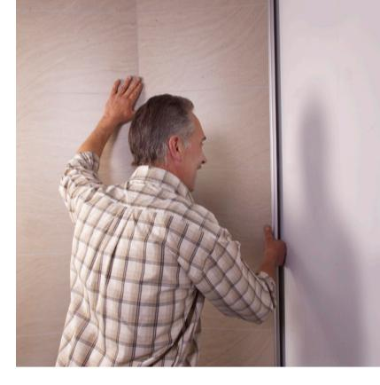
Bevestig het hoekprofiel op het paneel alvorens dit te plaatsen. Vergeet de sanitaire silicone niet!
