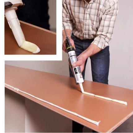
laat de panelen acclimatiseren en zorg dat de ondergrond voldoende vlak, droog, vast, zuiver, stof-en vvetvrij is. De ondergrond lichtjes opschuren geeft een beter resultaat.
