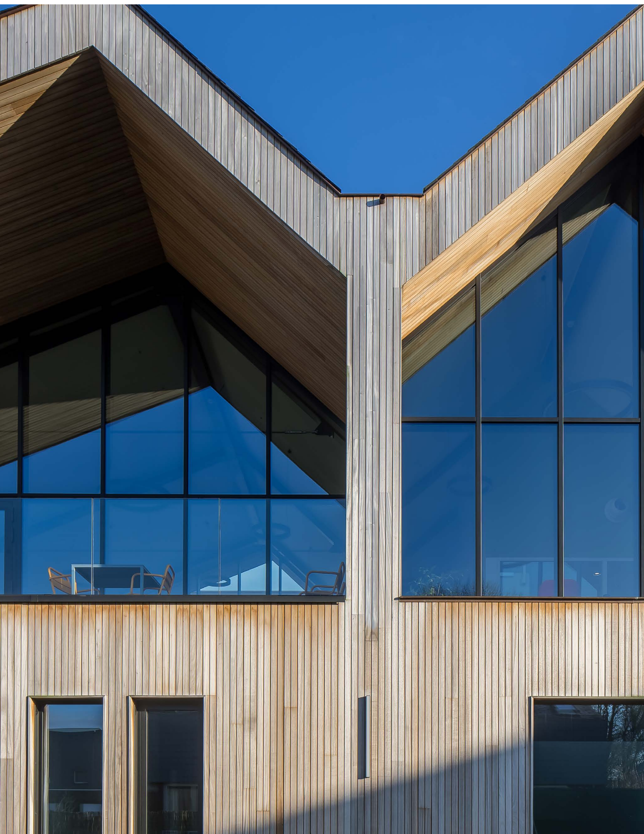
Projet : WZC Wielkine, Nazareth. Revêtement de façade en ThermoWood®, traité de manière ignifuge par Lemahieu Fire Protection® with Burnblock® jusqu'à B-s2,d0.
