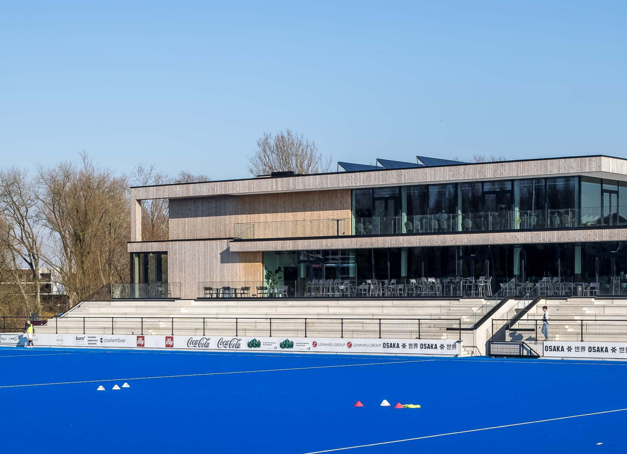
Projet Hockey & Padel Cantoise, Gand. Revêtement de façade en LDCwood® ThermoWood® pin raboté, traité de manière ignifuge par Lemahieu Fire Protection® with Burnblock® jusqu'à B-s1,d0
