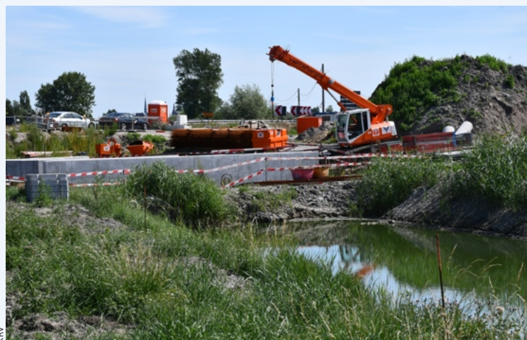
Aan de Speievaart wordt al druk gewerkt aan het installatie.
