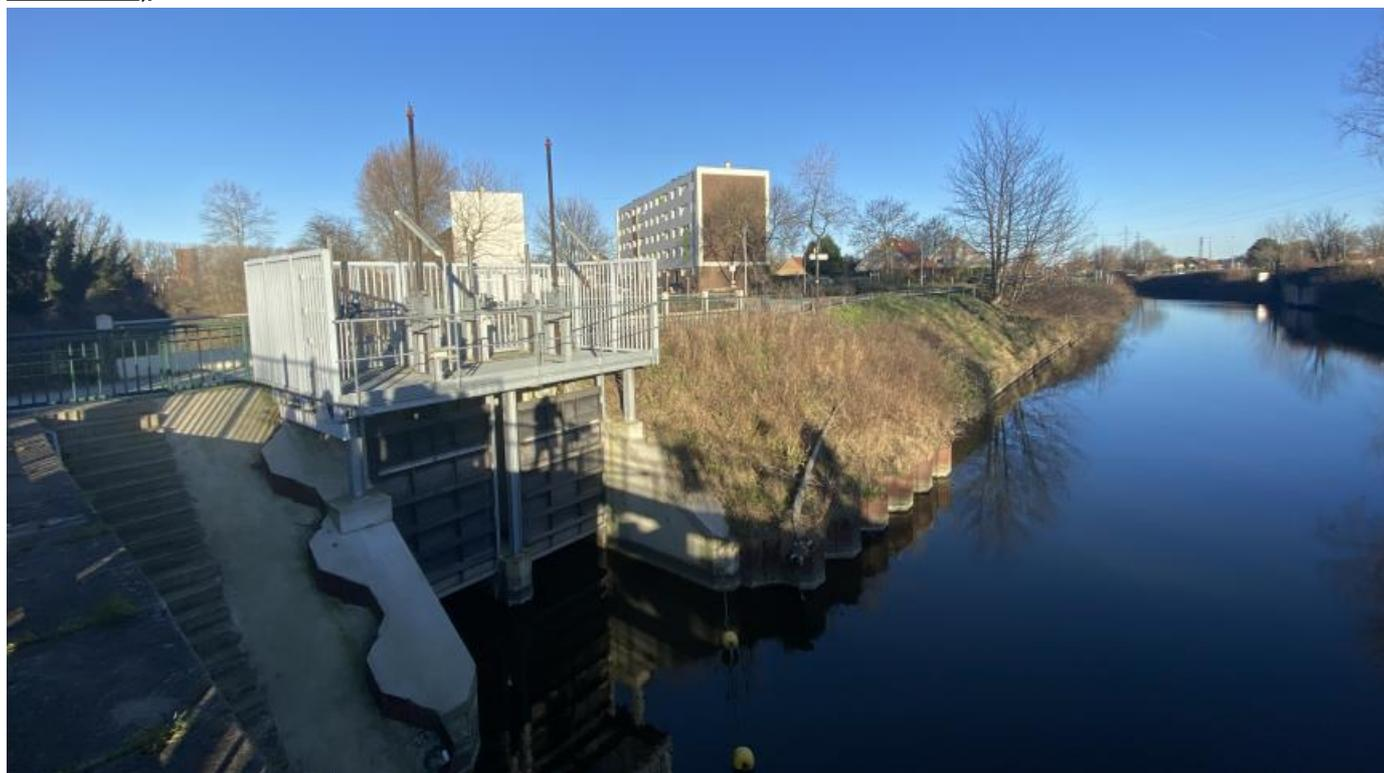
La vanne, construite en 2021 aux 4-Écluses à Dunkerque dans le cadre d'un projet cofinancé par l'Europe, crée une évacuation supplémentaire du canal de Furnes à la mer.
