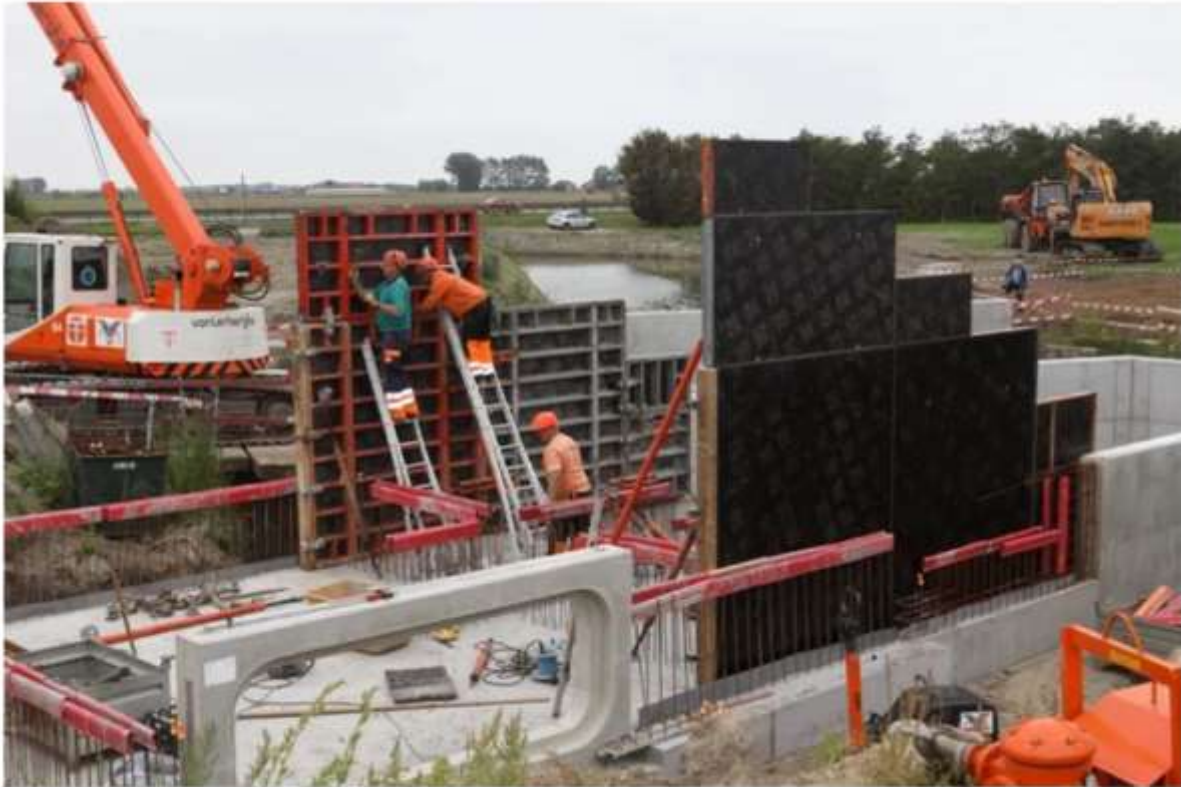
De werken aan het pompstation aan de Spelevaart zijn volop aan de gang. © MVP
