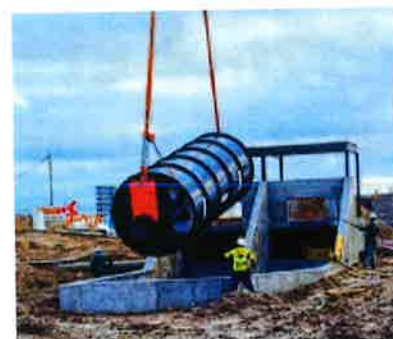
Durant les travaux, l'installation des vérins de la station de pompage du Speievaart.
