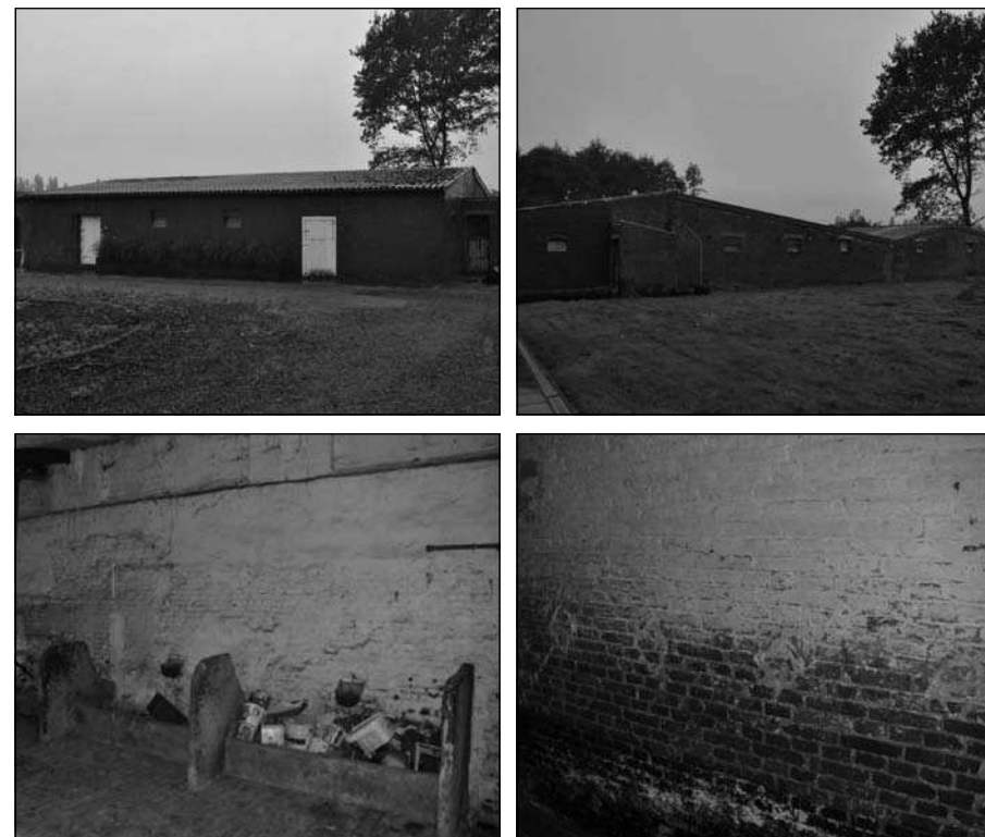
Tweemaal zicht op gebouw B en op de stallen met mogelijk een oudere muur.
