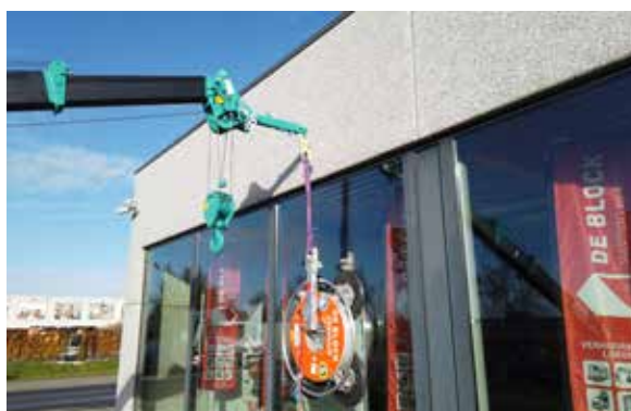
Gebruik van de searcher hook in combinatie met een vacuüm hijsunit voor glas
