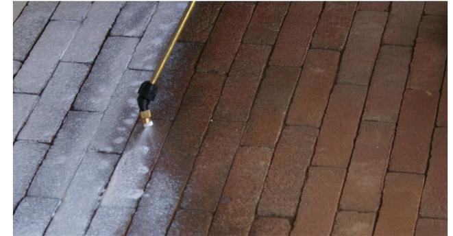
Pulvériser le SEAL-ALL® JOINT sur la surface pour saturer les joints.
