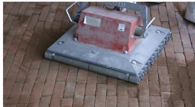
Densifier les joints de sable avec une plaque vibrante ou un marteau en caoutchouc pour que les grains de sables puissent effectivement être reliés.
