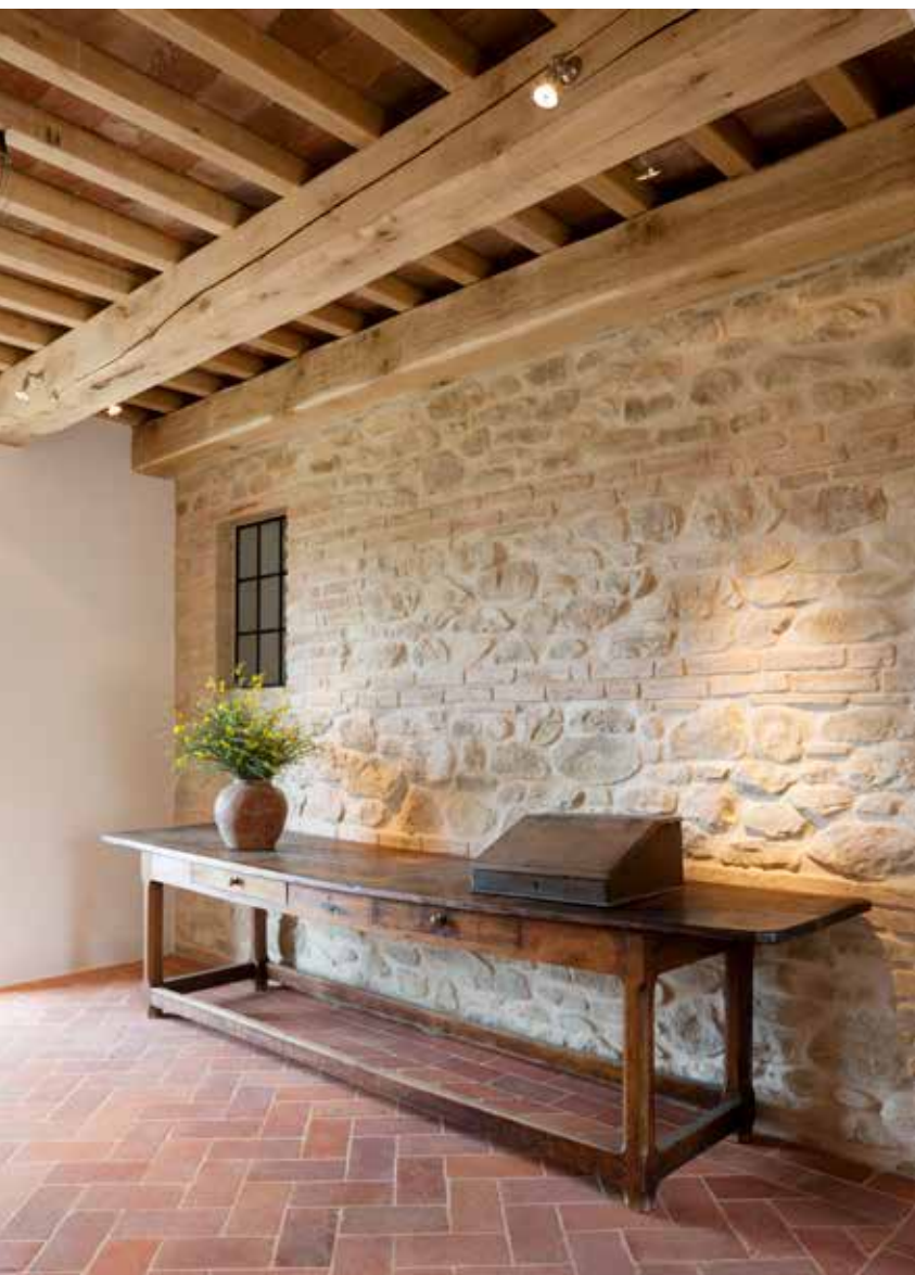
In de inkom, die het woongedeelte van het gastenverblijf scheidt, staat een oude kloostertafel. Hier liggen de vloertegels in visgraatmotief. Om de muur te verstevigen werd behalve met natuursteen ook met baksteen gewerkt.
